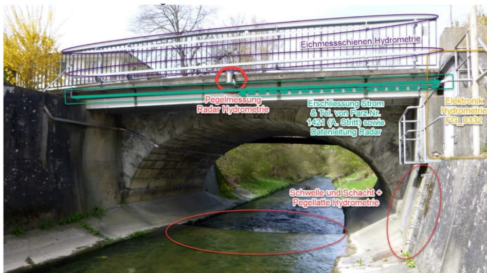
Abb. 7: Pegelmessstation ALG mit den einzelnen Komponenten
