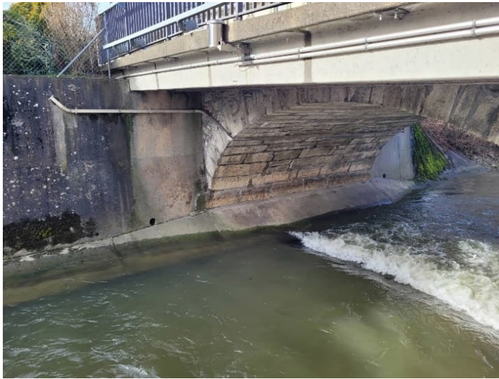
Abb. 6: Kommunikationsleitung Brücke Seite West
